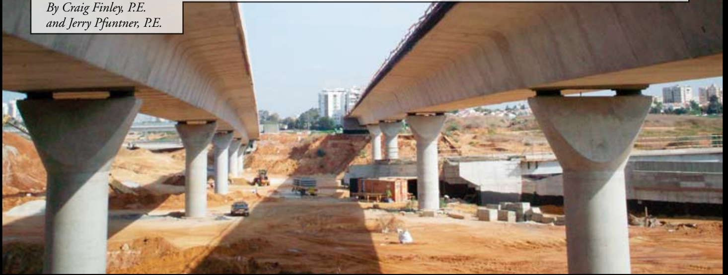
Bridge 22 and Bridge 23 of the Ein Hakore Interchange.
